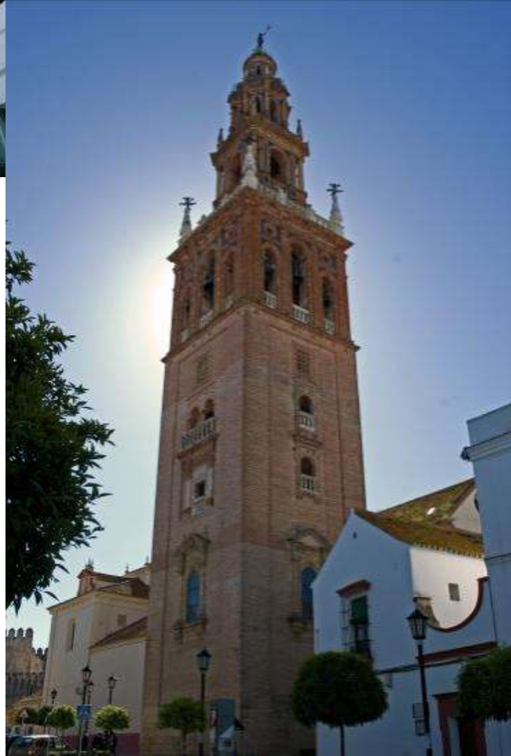
Torre de la Iglesia de San Pedro
